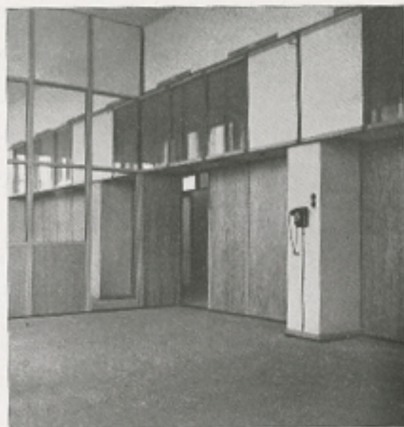
De wanden gereed, bezet met dubbele multiplex panelen of dubbele beglazing.
