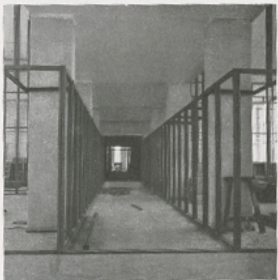
De stalen stijlen der gangwanden.
