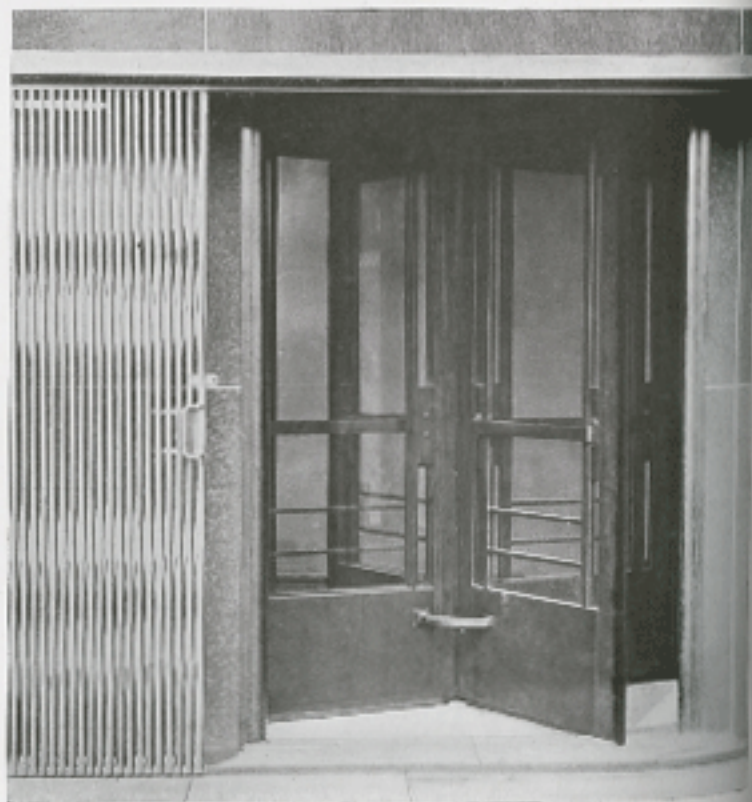
Bronzen tourniquet met schuifhek voor een flatgebouw te Rotterdam
