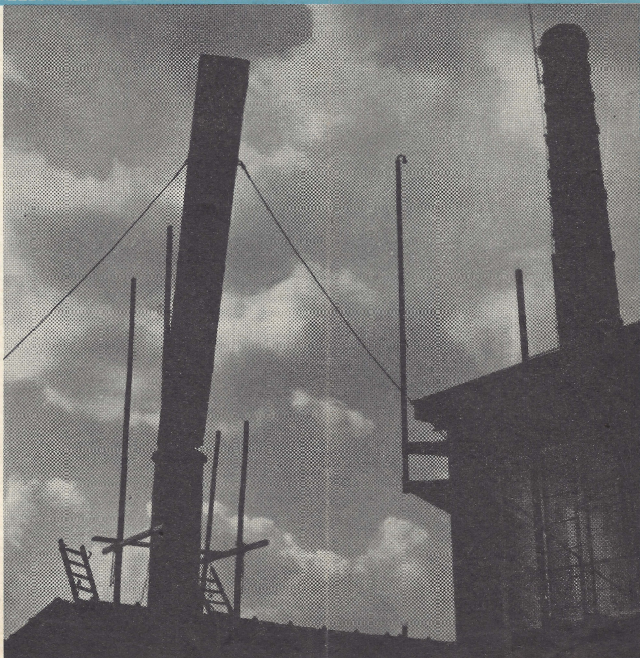
Het moment waarop de schoorsteen van de Schotse Ketel wordt omgetrokken.
