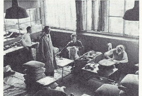
Waar nu het constructiebureau is werd toen gestoffeerd.
