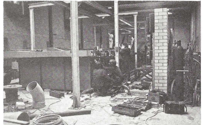
De galvanische afdeling in opbouw.
