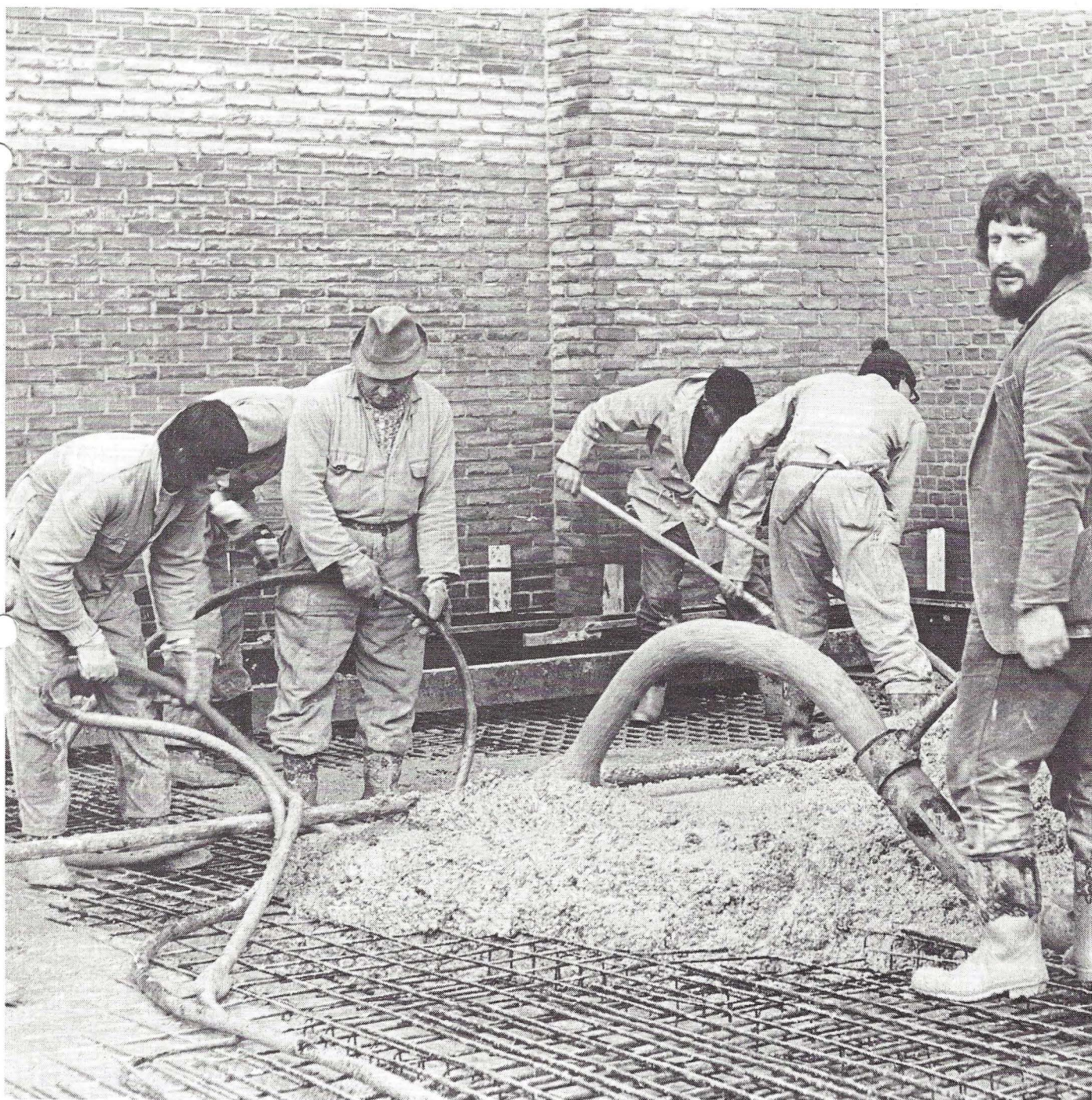
Betonspuiten voor de vloer van de nieuwe lakkerij.
