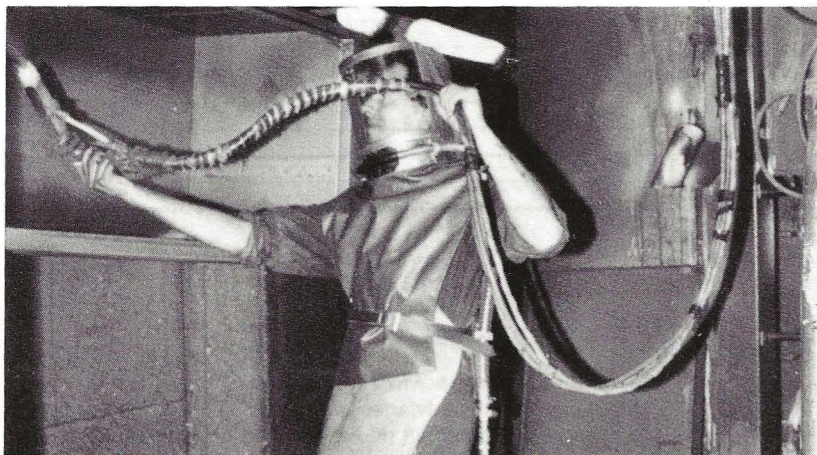
De figuur op bovenstaande foto is geen maanmannetje en ook geen space-shuttle-piloot, maar een Gispens medewerker die bezig is een zgn. 'manschappenkast' te spuiten.
