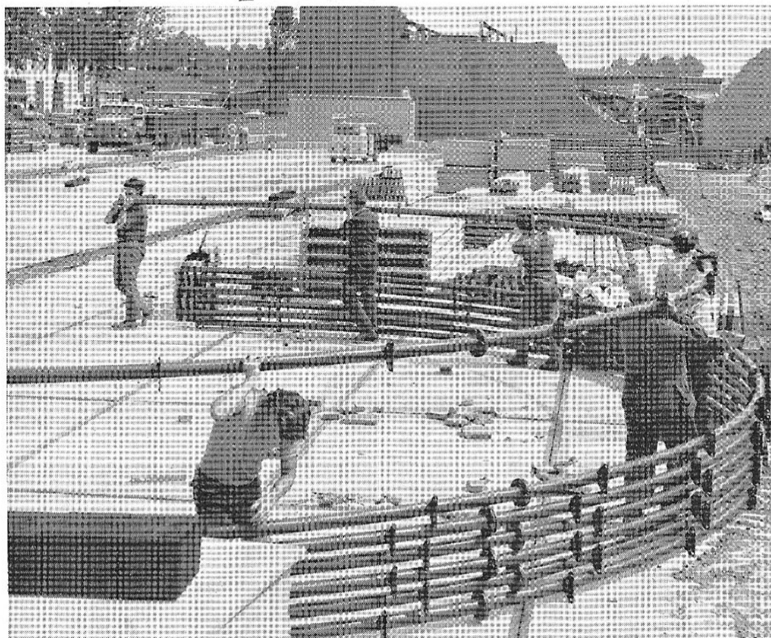
Intussen worden de spanten van de Romney-hallen opgezet.
