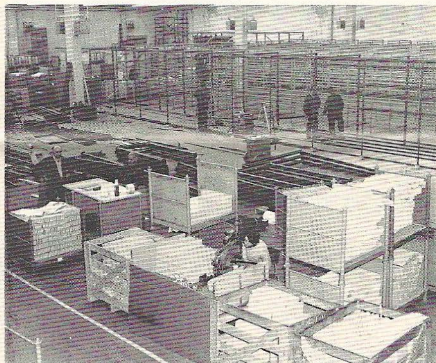
●opbouw van de doorschuifrekken
