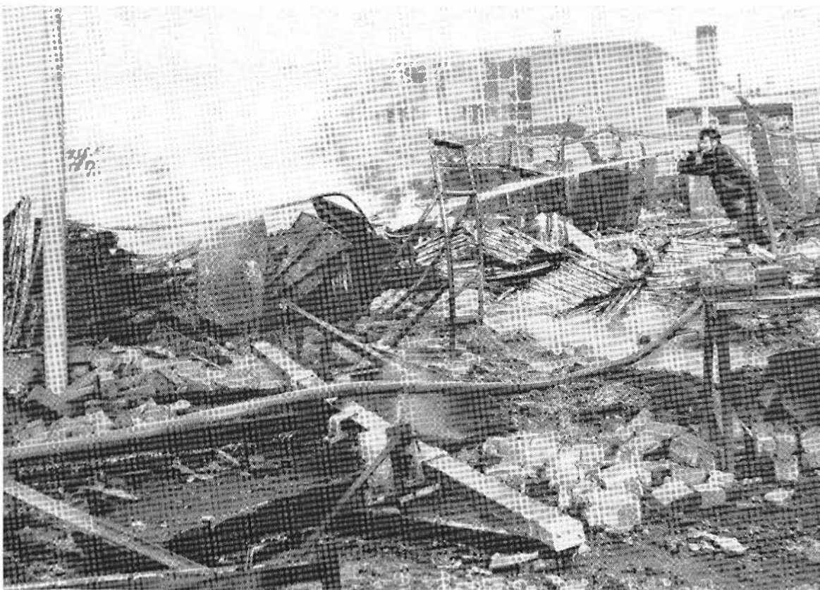
Het nablussen is begonnen
