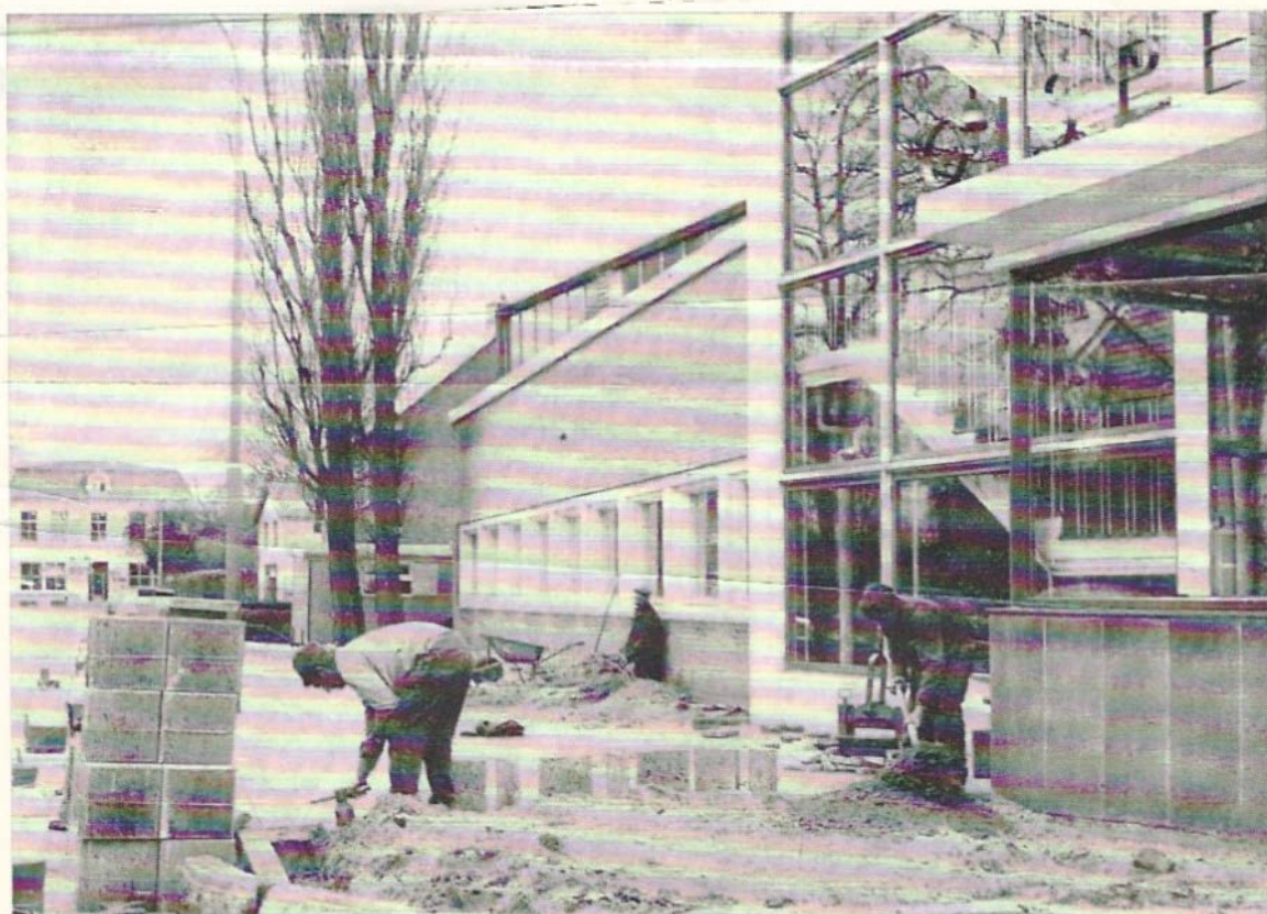
Het pas gelegde brede trottoir werd alweer twee maal opgebroken - door PTT en kabelmannen!
