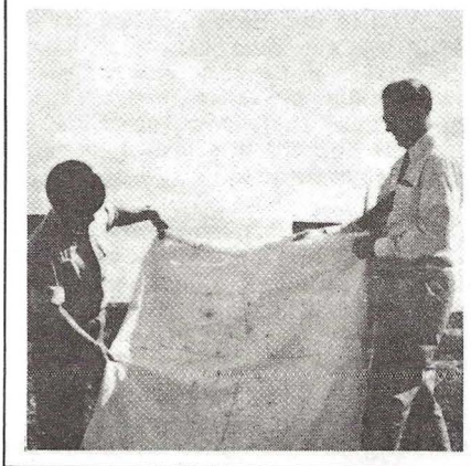
De bomdeken vóór en na gebruik, 16 lagen nylon op elkaar.
