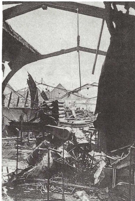
Wachtend op de sloper...
