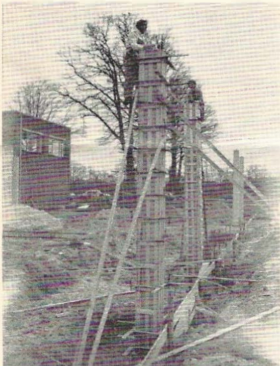
Het storten van de kolommen leek een eindeloze geschiedenis
