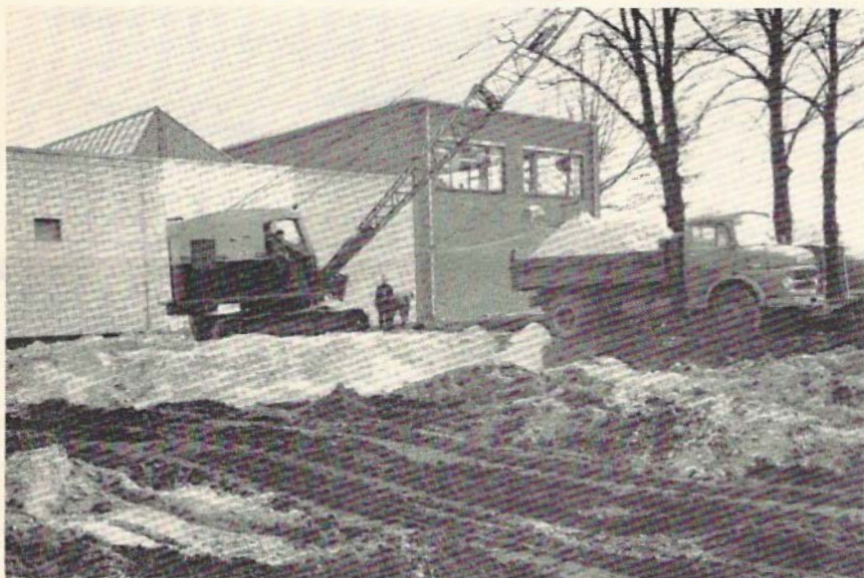
In april werd met de grondwerkzaamheden gestart
